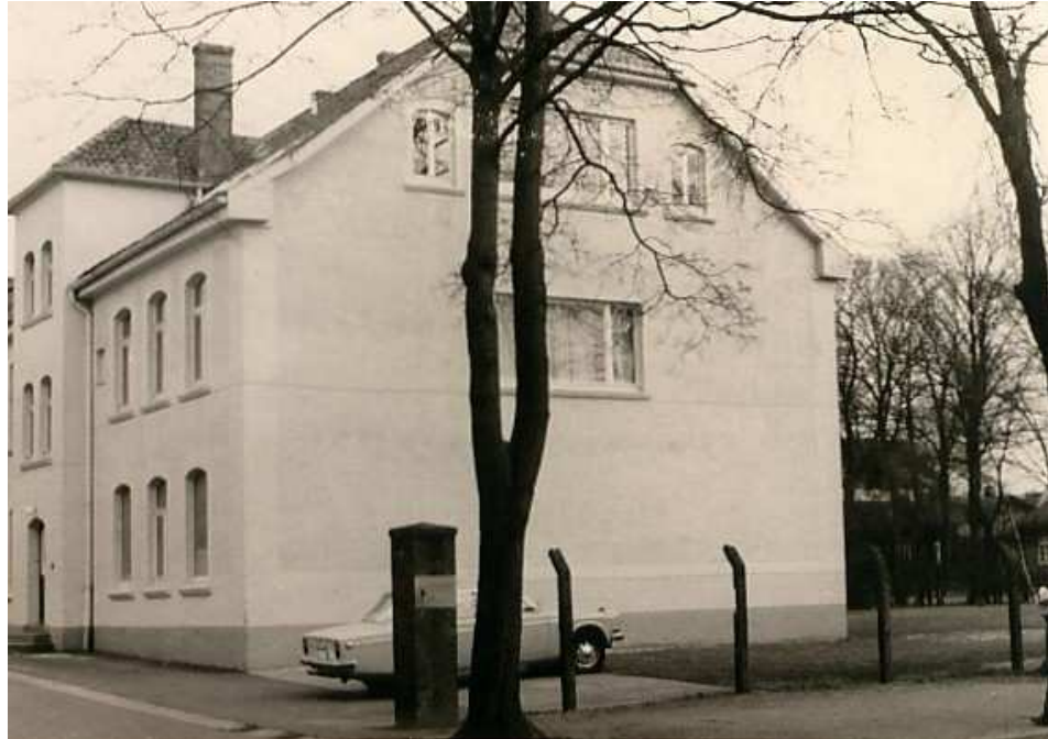
Abb. 50 Südwestansicht vor der Errichtung des Anbaus, 1960er Jahre
