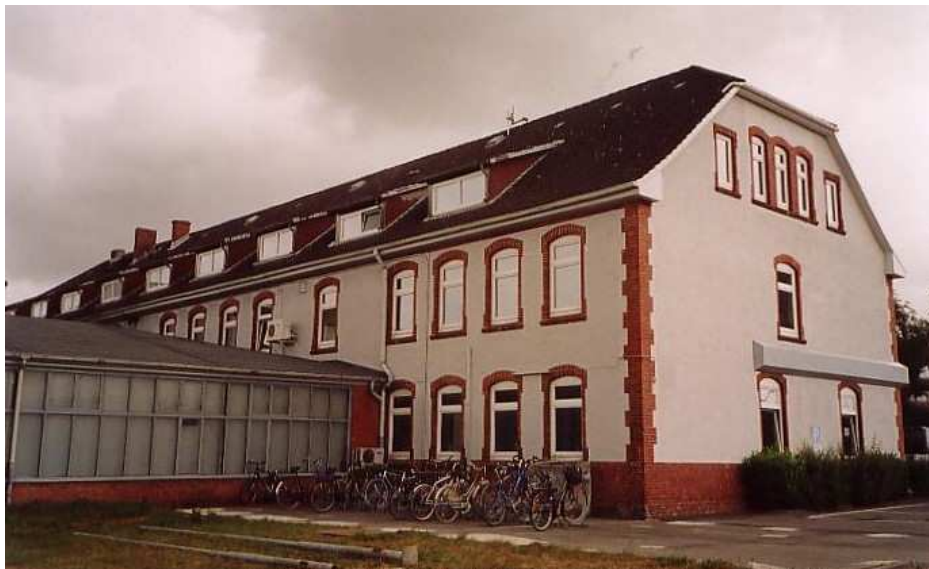
Abb. 36 Verwaltungsgebäude der Firma Nier (M.6), 2003
