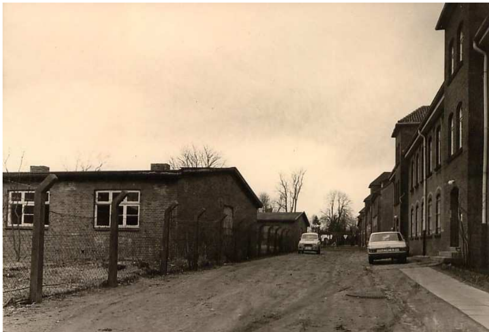
Abb. 45 Auffahrt zu M.1, M.4 und M.5, links die ehemalige Küche 8, 1960er Jahre
